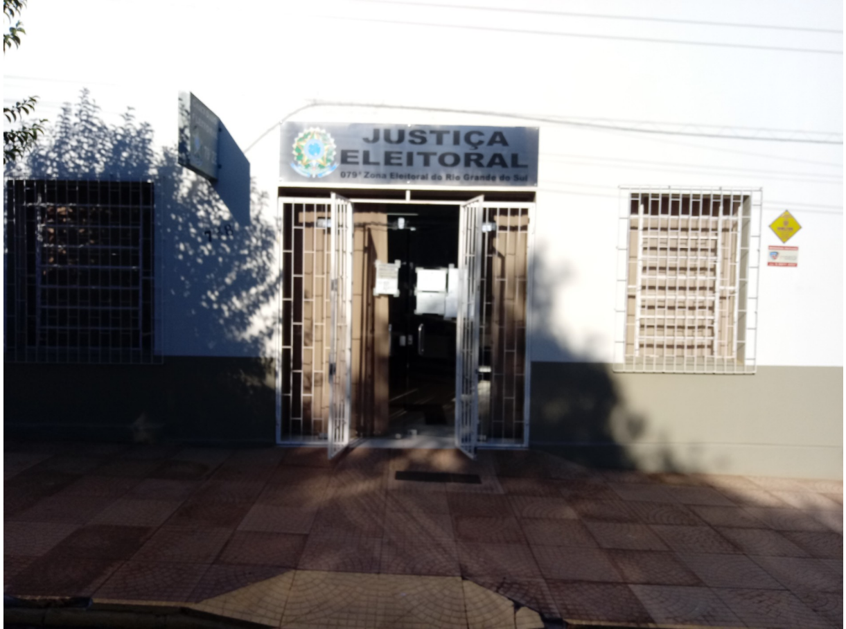
Foto 01: Fachada do Cartório Eleitoral, onde deverá ser instalado o toldo.
