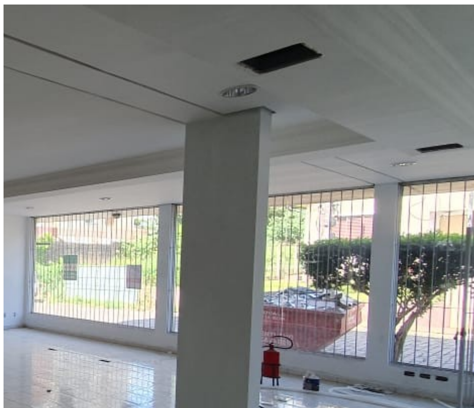
Foto 02: Local de instalação das persianas.
