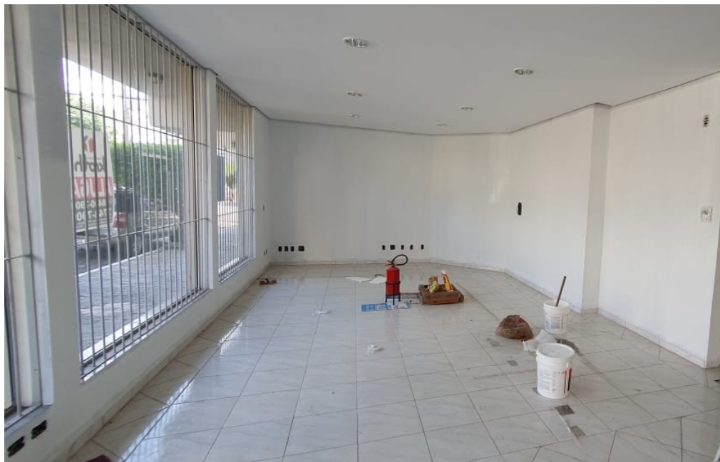
Foto 01: Local de instalação das persianas.
