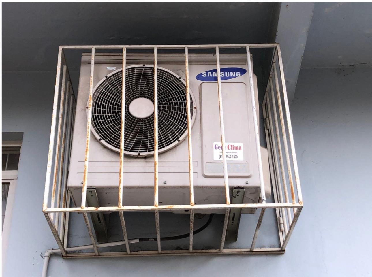
**Foto 02: Condensadora do equipamento.**
