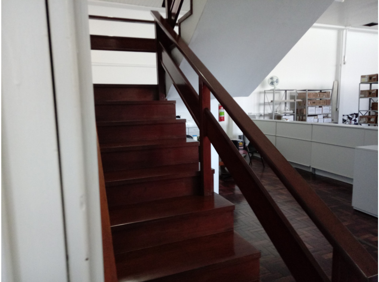
Foto 02: Escada de acesso ao andar superior no local de retirada.
