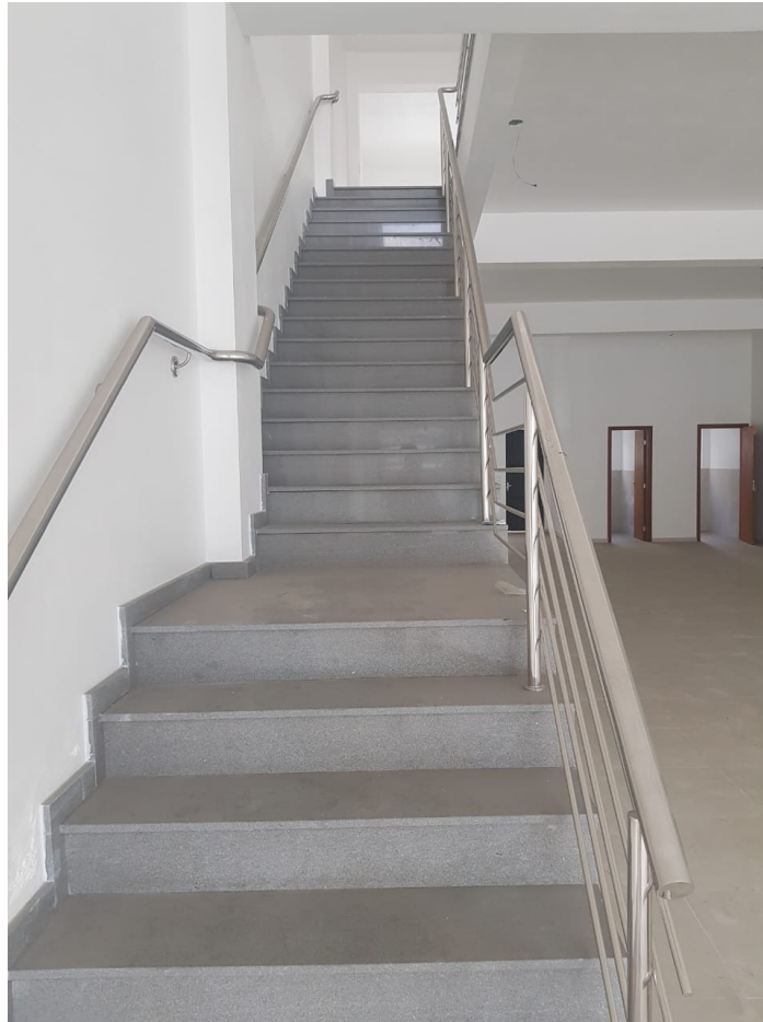
Foto 04: Escada de acesso ao andar superior no local de entrega.
