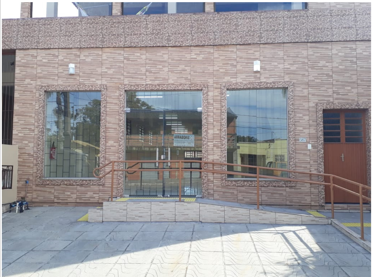
Figura 2 – Local onde a placa será instalada
