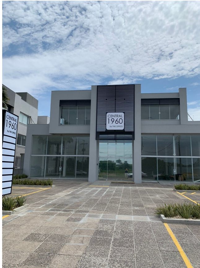
Foto 01: Local de instalação das películas.
