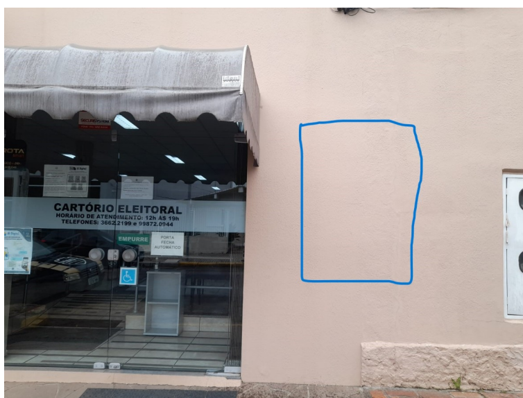
Foto 02: Parede na qual a placa deverá ser fixada.
